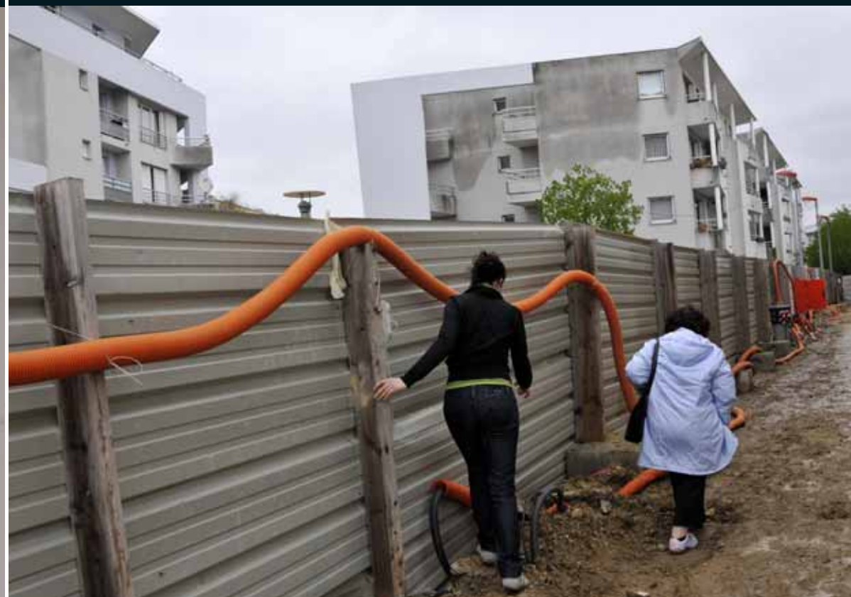
Mme Dardar / Visite du chantier Pottier-Timbaud / avril 2009
